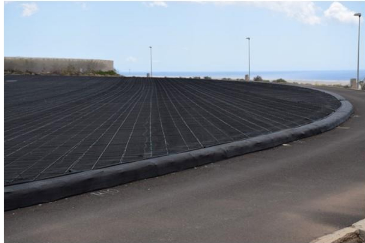
Figura 1.4. Cubierta de la balsa de El Saltadero.
