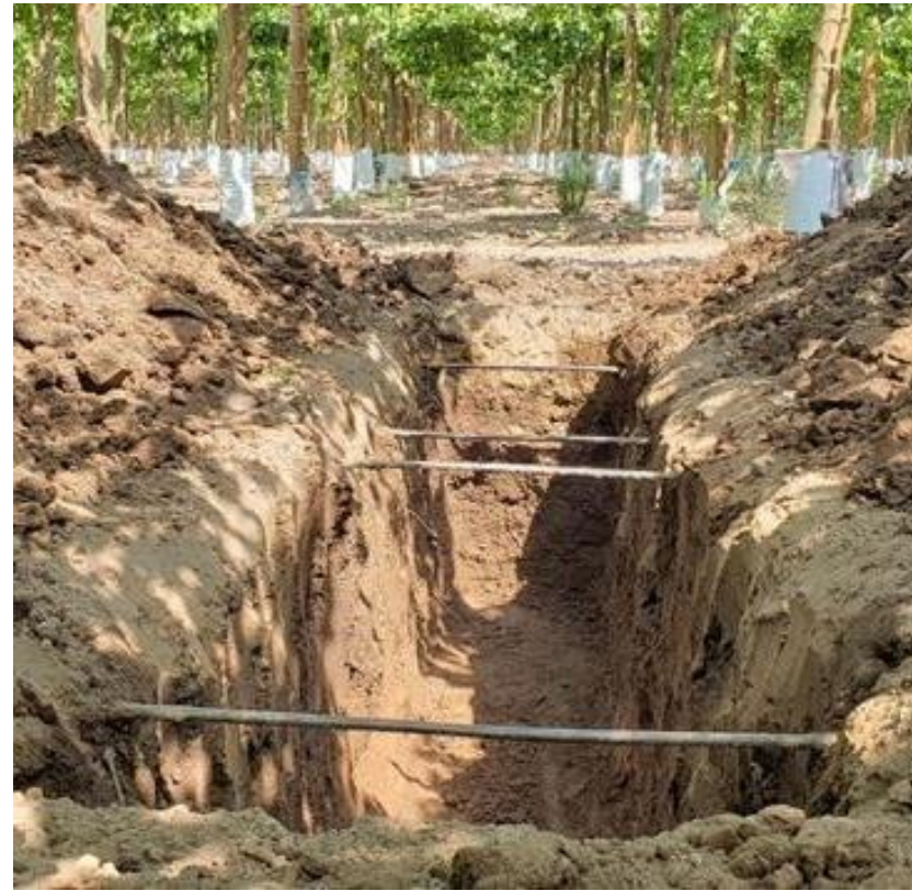
Sistema de riego localizado enterrado (línea completa o capsulas)
